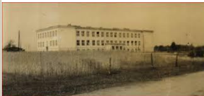
Budynek szkoły w m. Cegłów. Zdjęcie z lat 30tych XX w.
